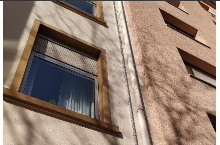
Weg 2: Kabelweg in einem Aluminiumfallrohr (links neben dem Fallrohr für Regenwasser)
