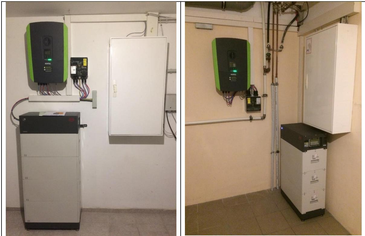
Platzbedarf im Hausanschlussraum. Wechselrichter (grün) mit angrenzendem DC-Überspannungsschutz (kleiner Kasten). Auf dem Boden stehend befinden sich die Batteriespeicher (links 11kWh, rechts 7,7kWh)
