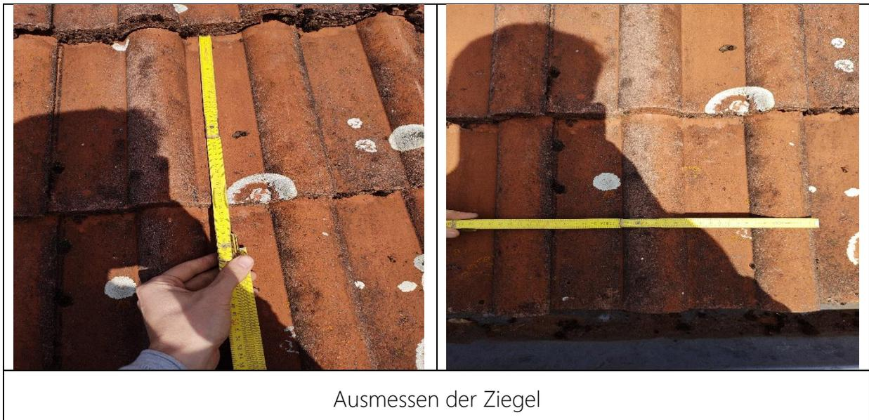
Nachdem Sie einen Ziegel ausgemessen haben, bitten wir Sie darum einige Ziegel hochzuschieben und die darunter befindenden Dachsparren, Dachplane und (sofern vorhanden) die Aufsparrendämmung zu fotografieren. Dies hilft uns einzuschätzen, in welchem Zustand sich Ihr Dach befindet. Sollte Ihr Dach über eine Aufsparrendämmung verfügen, dokumentieren Sie bitte dessen Höhe.
