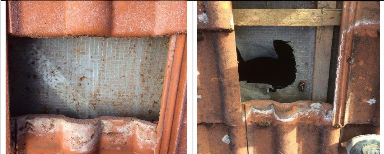
Zustand der Lattung und Unterspannbahnen zweier Dächer ohne Aufsparrendämmung
